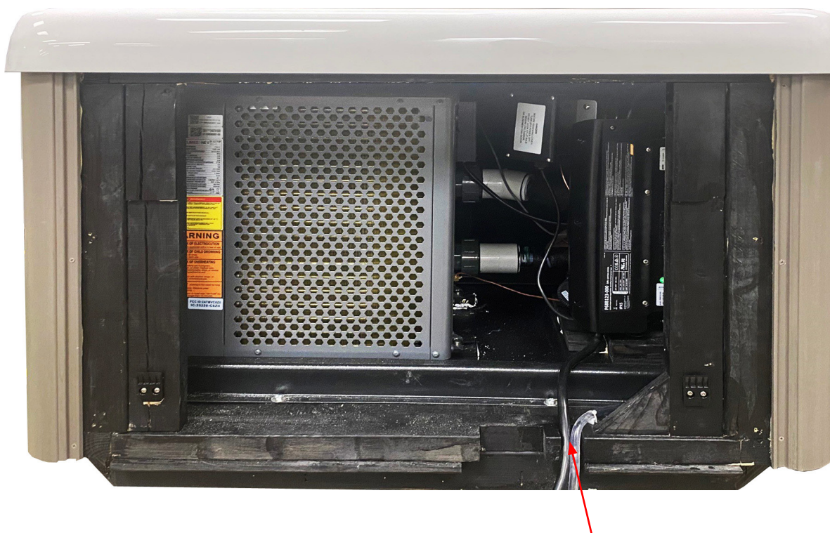
Netzkabel und Abflussrohr im ausgeschnittenen Bereich
